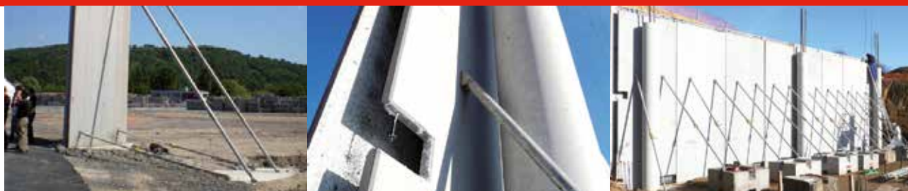
10 Etançon de pied pour faire un stabilisateur 11 Chapes d'extrémité 12 Contrepoids béton
