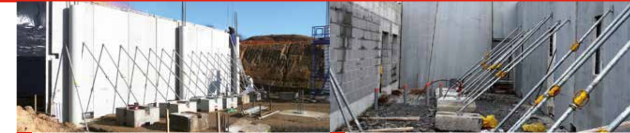
7 Sur prémurs de 6 mètres. 8 Sur prémurs de 3 mètres.
