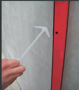
**3** Tourner de 90° et tirer l'ancrage FLUXX pour bloquer en place le profilé FLUXX
