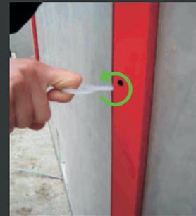
Vérifier que le profilé est bien en place et bien fixé avant d'effectuer le bétonnage !
