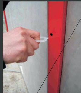
**4** Le démontage est effectué en tournant l'ancrage FLUXX jusqu'à la rupture
